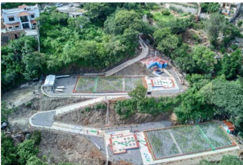
Foto: Parte del Sistema Descentralizado de Tratamiento de Aguas Residuales
